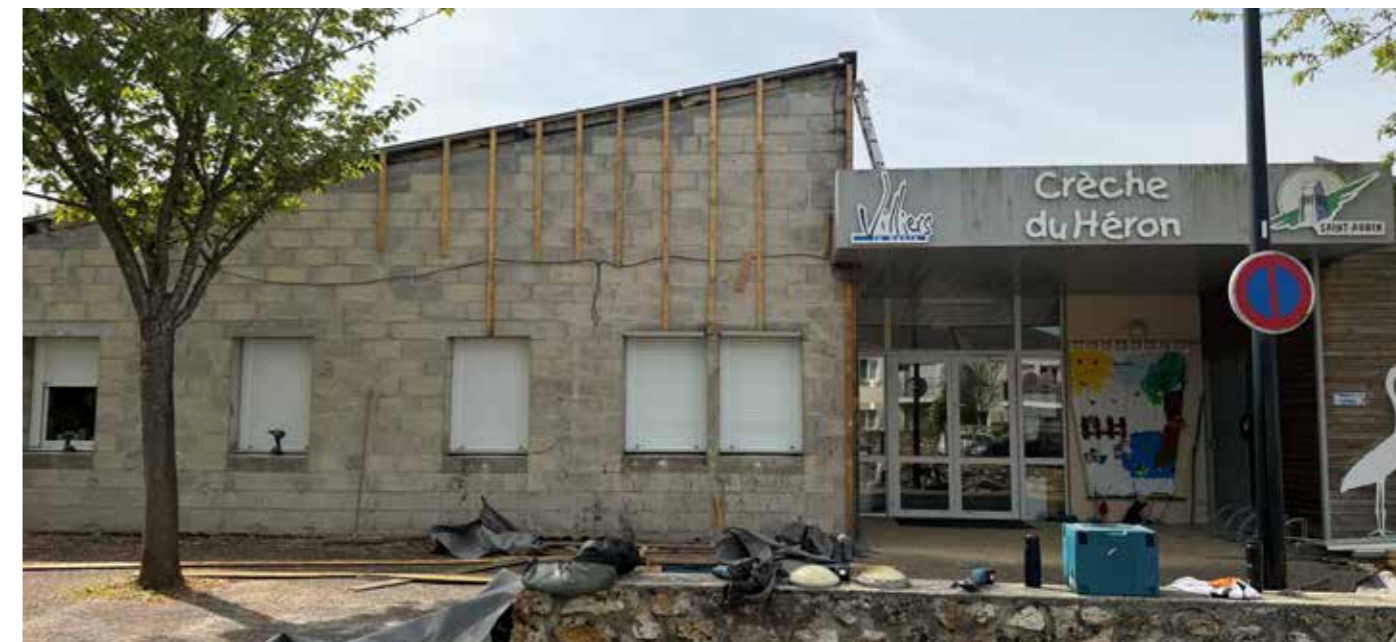
La façade de la crèche pendant les travaux
